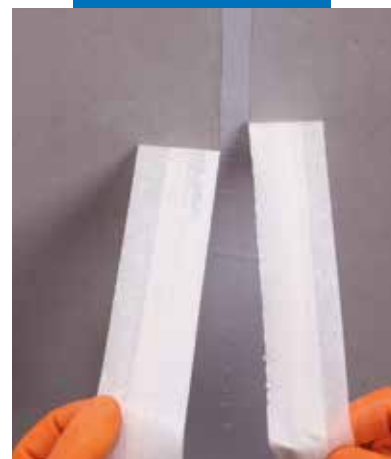
Retirada de la marca realizada previamente con cinta adhesiva, para evitar el reboso
